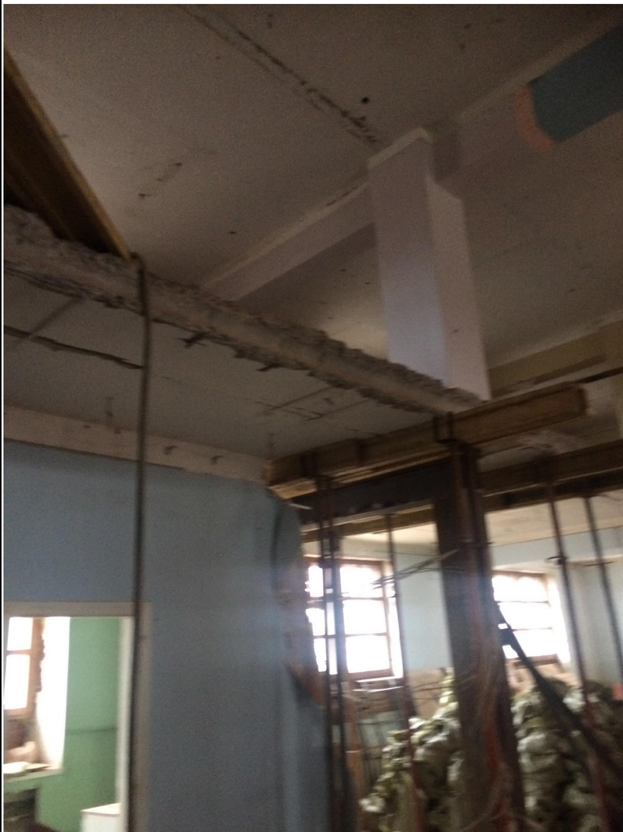
Фото 4. Поздние железобетонные перекрытия 2010 г..
