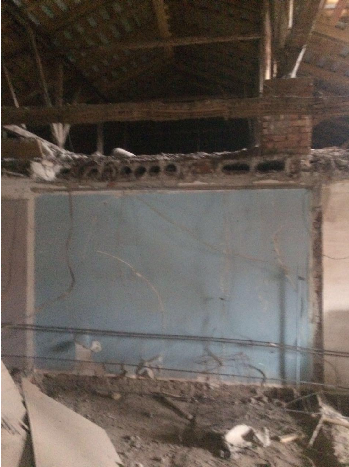
Фото 3. Поздние железобетонные перекрытия 2010 г.
